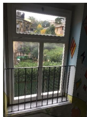
Figura 4-4 - Particolare dei serramenti
