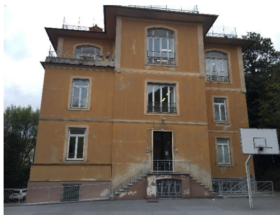
Figura 1-1 - Vista della facciata esposta a Sud
